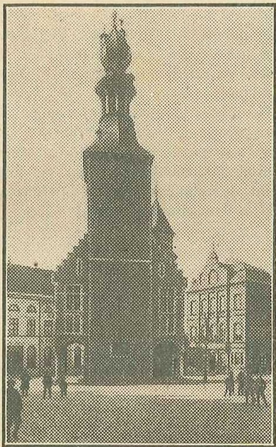
Halletoren te Tiel
